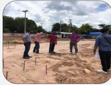
งานควบคุมงานอาคารผู้ป่วยนอก โรงพยาบาลม่วงสามสิบ
