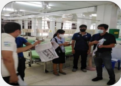
งานควบคุมงานหอพักผู้ป่วยติดเชื้อ COVID- ๑๙ โรงพยาบาลวารินชำราบ
