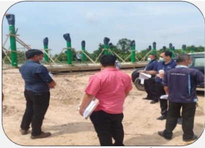
งานควบคุมงานอาคารทางเชื่อมอาคาร โรงพยาบาล ๕๐ พรรษามหาชิริาลงกรณ์
